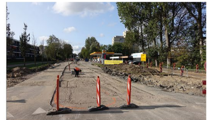
Circulair: Fundament van puin Kon Julianalaan.
