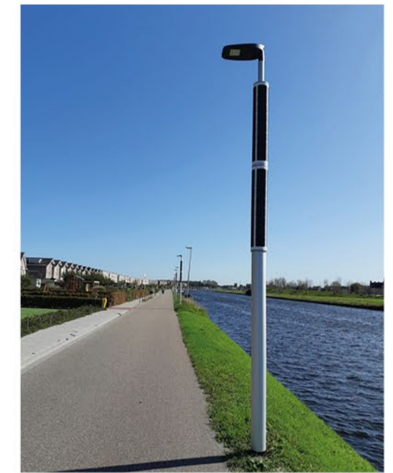
Lichtmasten met zonnecellen langs het Kanaalpad
